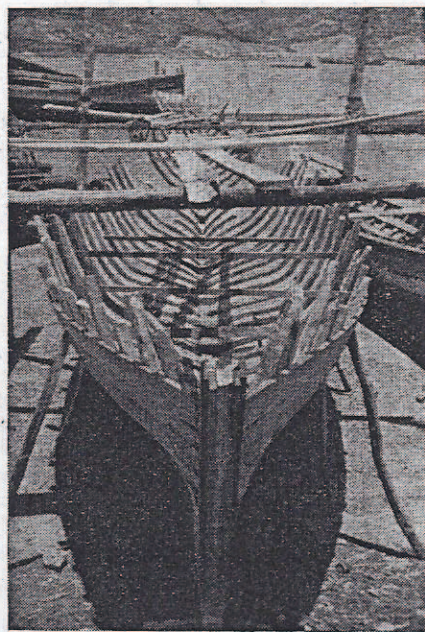
5. — Détail de construction d'une embarcation de type local, mais amélioré à Aden ; les membrures ont été renforcées et des varangues leur ont été adjointes.
